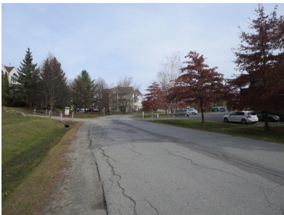
Voisinage vers le nord
