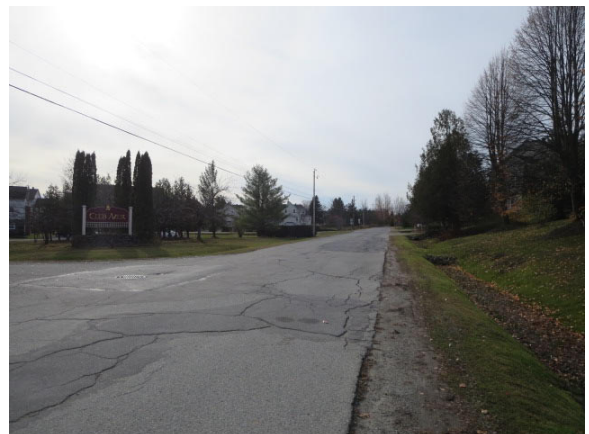
Voisinage vers le sud
