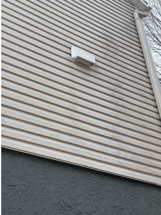
[Façade droite du bâtiment]
