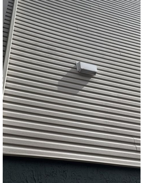
[Façade gauche du bâtiment]
