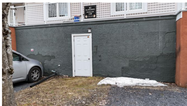
[Façade arrière du bâtiment]
