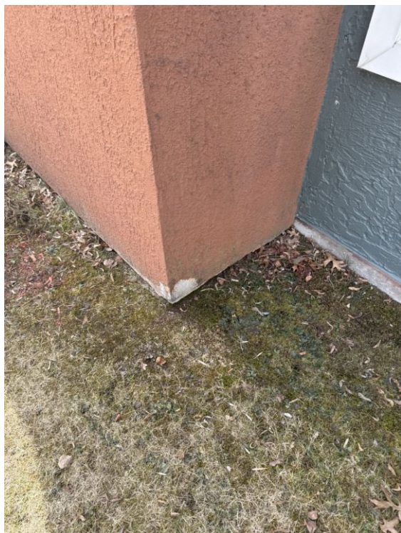
[Façade droite du bâtiment]
