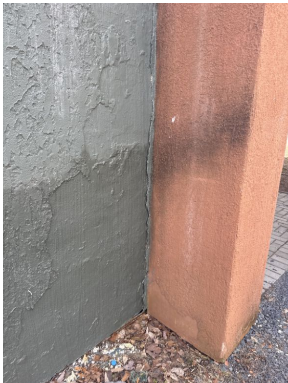
[Façade arrière du bâtiment]
