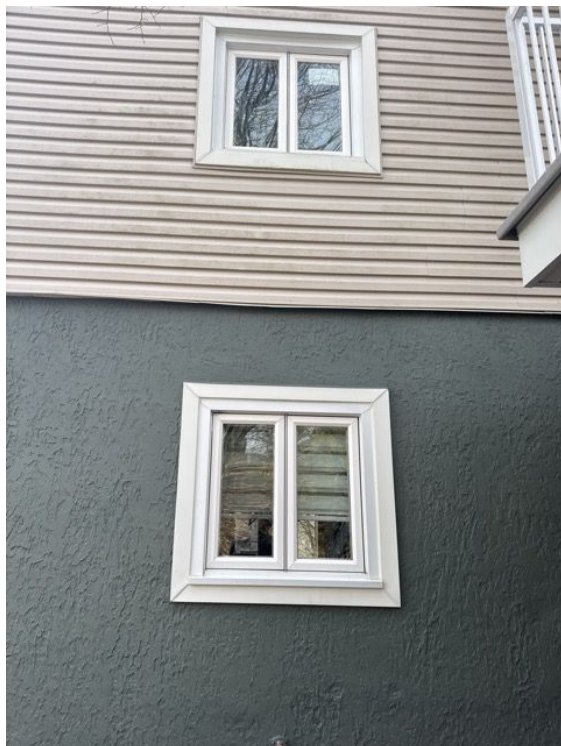
[Façade arrière du bâtiment]
