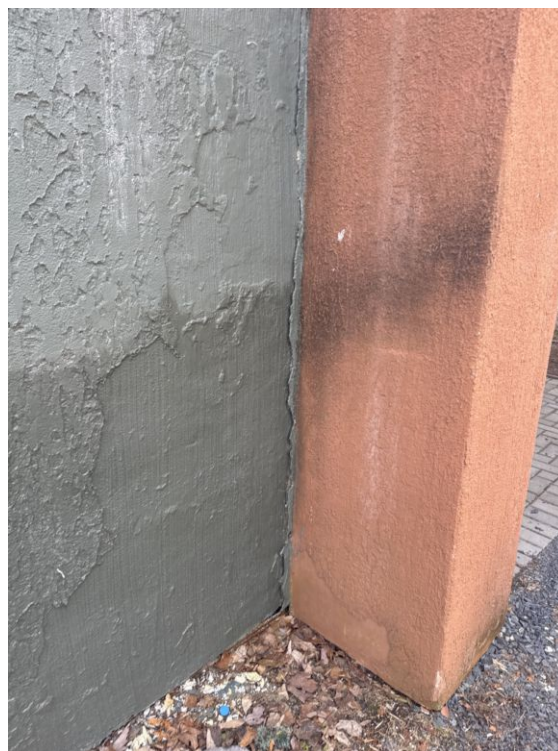
[Façade arrière du bâtiment]
