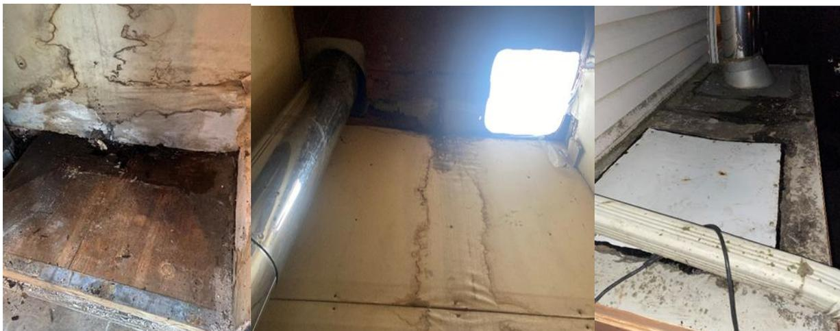
**22 décembre 2023** Comme il y a infiltration d'eau par le toit qui a une pente négligeable et que l'imperméabilité du toit semble aussi problématique à long terme j'ai fait parvenir une demande de soumission au
