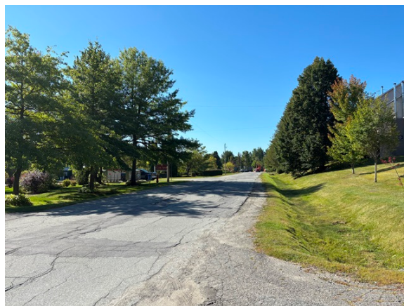
Vue du voisinage en direction sud
